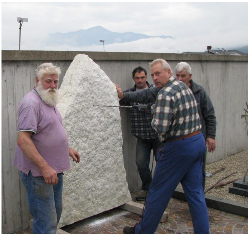
Il blocco è quasi a posto ma si rende necessario forarlo per poi ancorarlo al muro. Qui vediamo Marco ed Emilio Pergher, Ivo e Pio Piva al lavoro.
